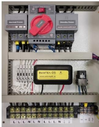
Компания «Русинжгрупп» представляет свою новую разработку - универсальный блок автоматики «АВР РИГ 3-1-63». Предназначен для автоматического запуска однофазных и трехфазных газовых и бензиновых электрогенераторов.
